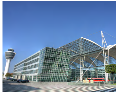
Der Flughafen München, Deutschlands zweitgrößter Airport, verlässt sich bei der Löschwasserversorgung auf Produkte von ERHARD. Als Endpunkte des Löschwassernetzes, dessen Pumpen zusammen 60.000 Liter pro Minute bei 7 bar Druck liefern, kommen zahlreiche Hydranten in Über- und Unterflurausführung zum Einsatz.
